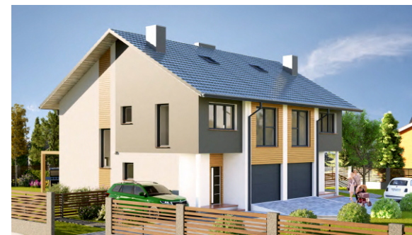
Tył budynku - część wspólna
